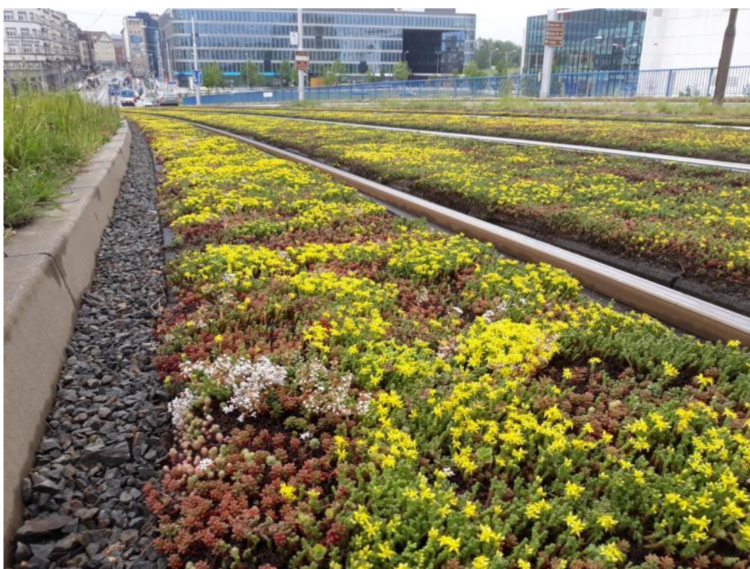
Kolejový absorbér hluku s funkcí retence vody BRENS STERED, foto: archiv Brens Europe
